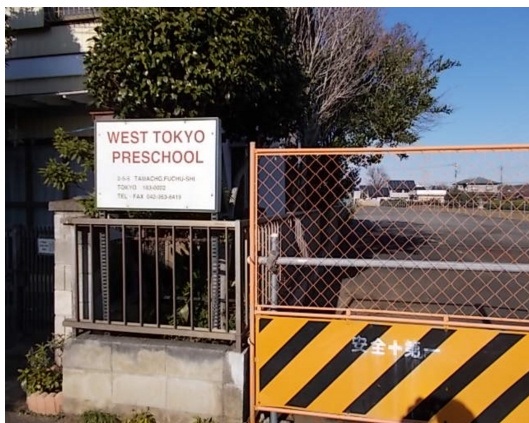
府中3・4・16号線1期区間にはまだ家が残っている
